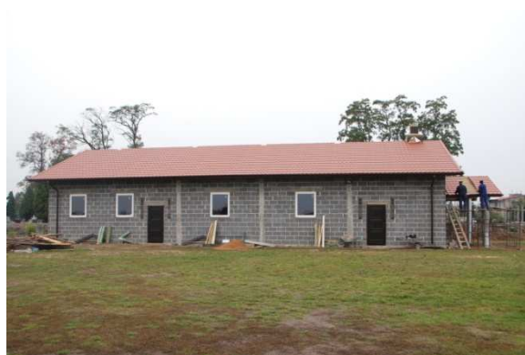
Fot.6. Widok na kaplicę, obiekt tymczasowy, budowaną na potrzeby parafii do czasu budowy kościoła.
