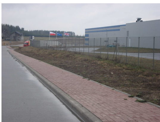
Zdj.3. Ulica Wiejska i hala firmy YKK
