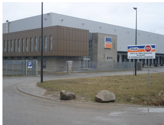
Zdj.4. Magazyn Firmy Plus wzdłuż ul. Tarczyńskiej
