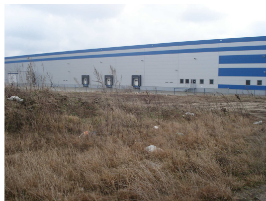
Zdj. 2. Hala Magazynowa w centralno-zachodniej części Planu – w trakcie rozbudowy
