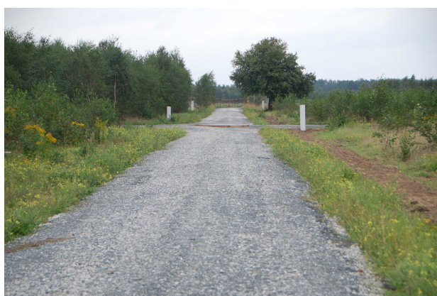
Zdj.3. Widok na teren drogi wewnętrznej we wschodniej części Planu, oznaczonej na rysunku Planu symbolem 1KDW.
